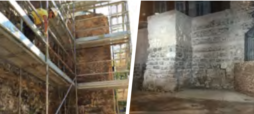
Detalle del proceso de rehabilitación de la muralla y posterior resultado desde el parque del Emir Mohamed I.
