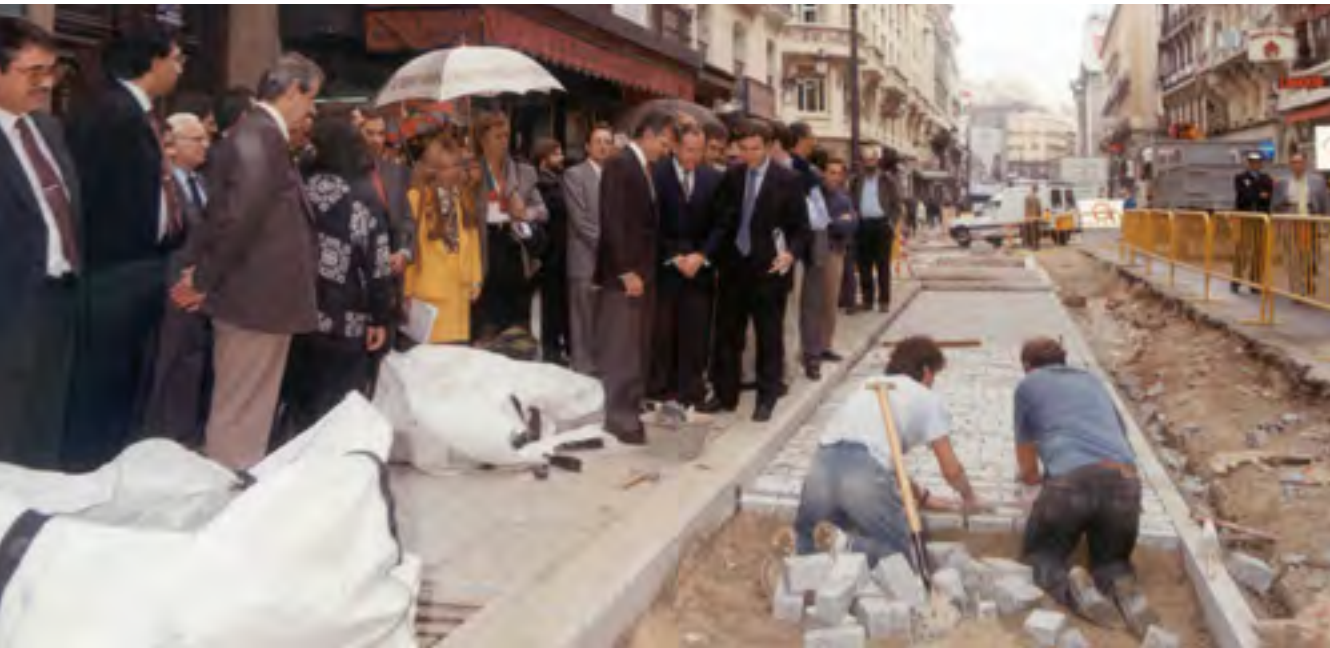
Visita del alcalde Álvarez del Manzano a las obras de rehabilitación de la calle Mayor .
