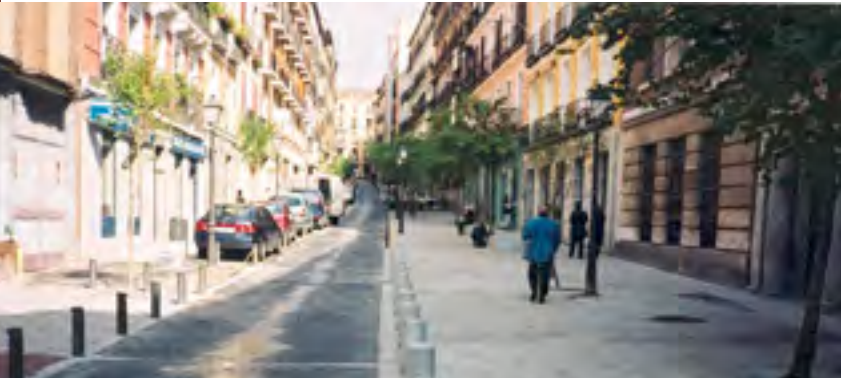
Rehabilitación de la calle Valverde. A la izquierda, vista del Tribunal de Cuentas y el Museo de Historia de Madrid, tras la obra de la calle Fuencarral.
