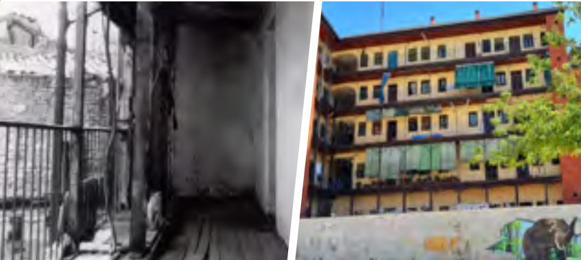
A la izquierda, una de las corralas antes de su rehabilitación. A la derecha, la conocida y patrimonio nacional Tribulete 12, tras las obras.
