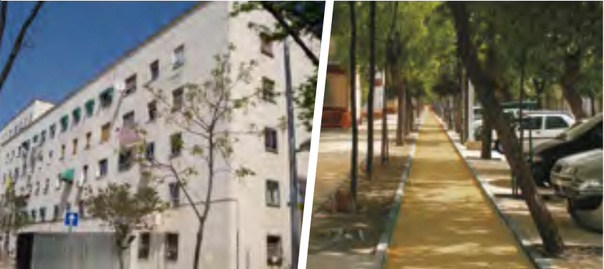
Canción del Olvido Nº24 antes de la intervención, a la derecha el nuevo carril bici incluido en el proyecto.
